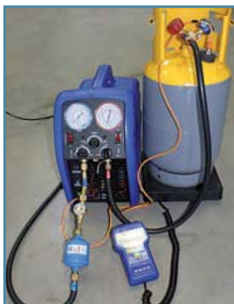
Príklad 8: Zostava odsávačky a fľaše na odsávanie s pripojenou ochranou proti preplneniu
