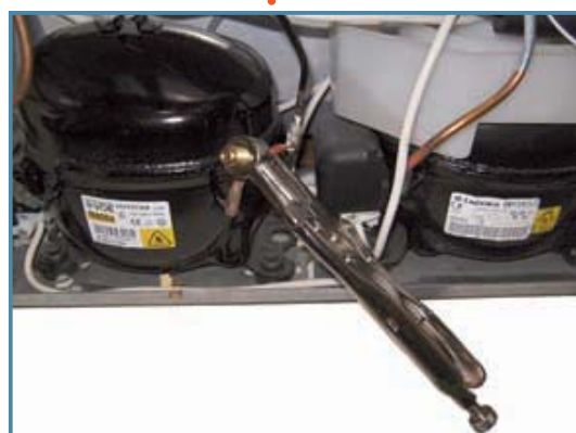
Príklad 6: Kroky pri otváraní chladiaceho okruhu
