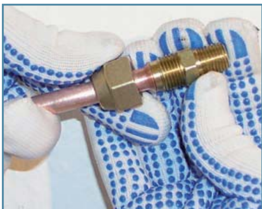
Príklad 8: Skladanie kalíškového spoja
