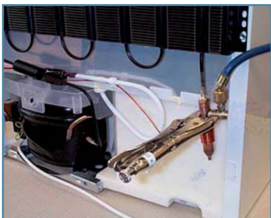
Príklad 8: Umiestnenie dodatočného servisného ventilu
