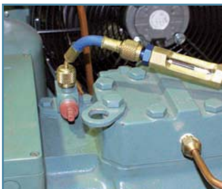
Príklad 15: Test kyslosti oleja na sacom potrubí
