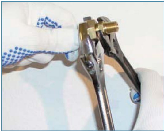
Príklad 9: Uťahovanie kalíškového spoja
