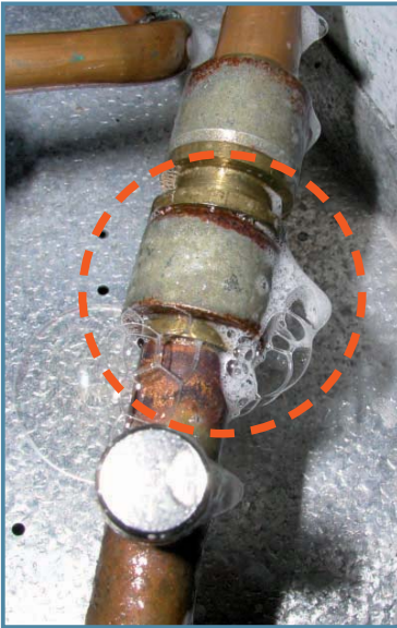
Príklad 23a: Príklad netesného spoja (vidieť bublinky)
